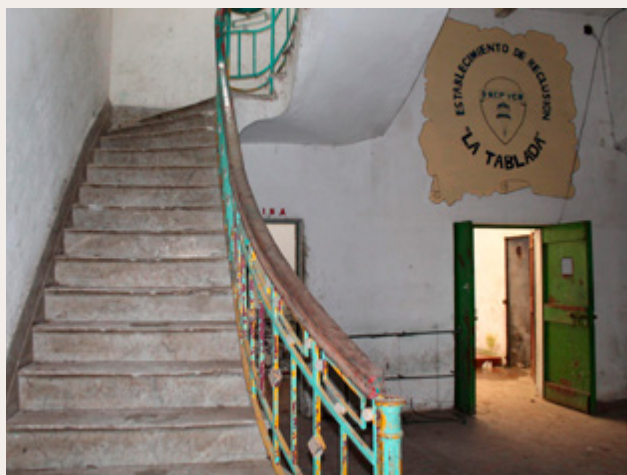
Escaleras de La Tablada Nacional fotografiadas tras su abandono como Establecimiento de Reclusión La Tablada. Año 2014.
